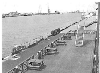
港に面したウッドデッキ
