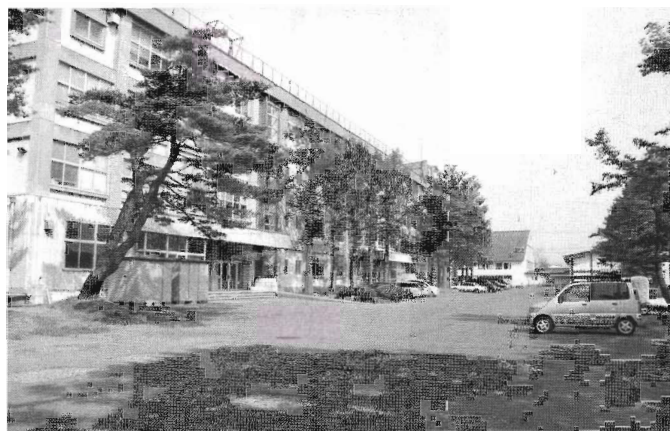
現在の本校舎。新校舎完成後解体撤去されます
